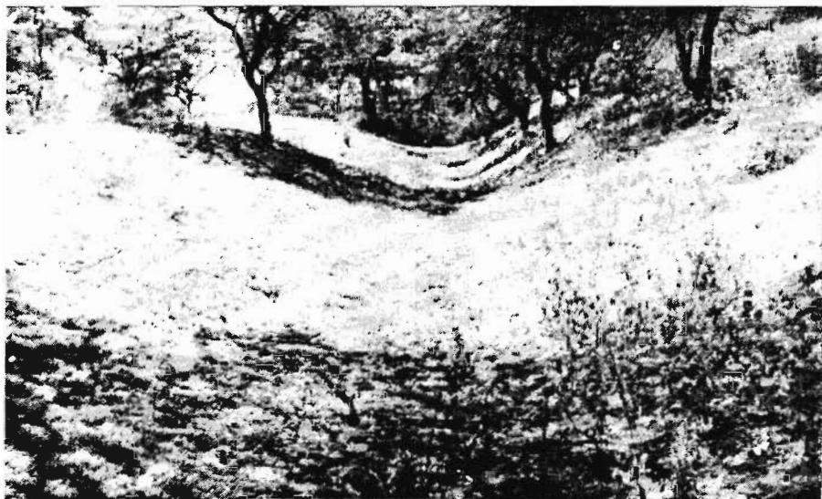
Fotografía que muestra el cauce del sepultado canal en la zona de Nómala en lugar conocido como el Sausal.
